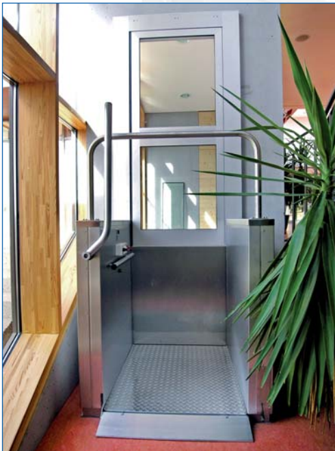
Lift cu platformă pentru scaune cu rotile cu ușă cu înălțime completă (model special), montat la o școală primară
