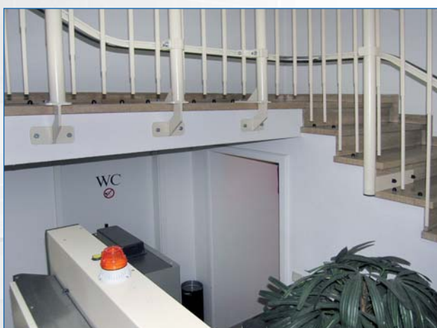
HIRO 320 - Șine de ghidare fixate cu o combinație de stâlpi montați pe marginea scărilor și traverse înainte de contratrepte
