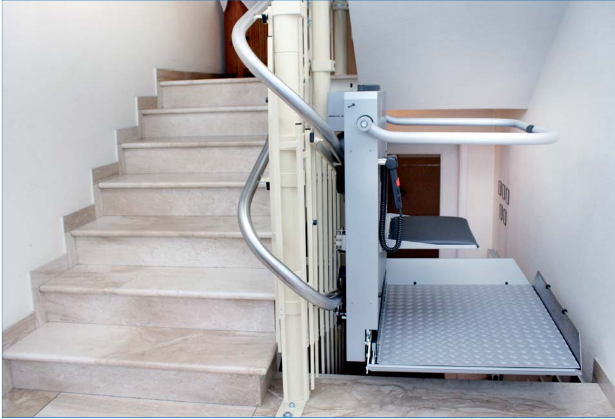
HIRO 320 - cu scaun pliant (dotare opțională), cu șine de ghidare montate pe stâlpi în casa scării
