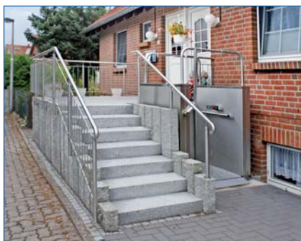
Lift cu platformă la intrarea unei case private.
