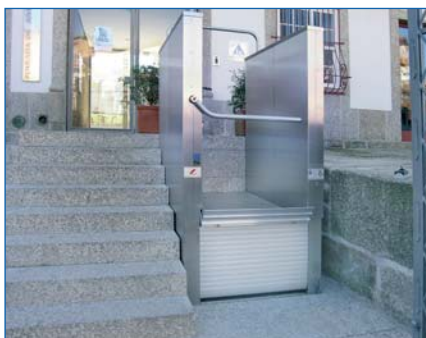
Lift cu platformă în fața unei clădiri publice
